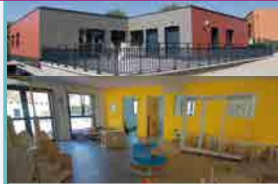
Même au mois d'Août, la municipalité s'active pour préparer la rentrée Travaux micro-crèche pour une ouverture au 2 septembre
