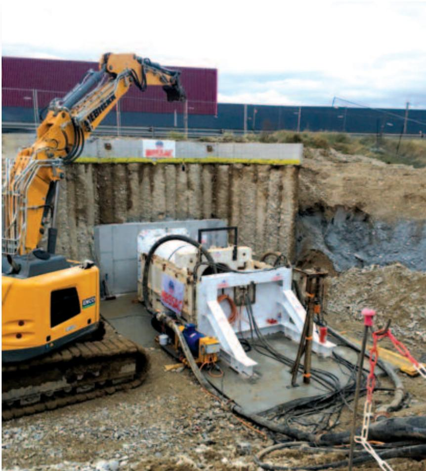
**La 3CM a réalisé un second fonçage (après celui de DAGNEUX déjà en service) sous l'autoroute A42 pour relier le réseau d'assainissement LA BOISSE-MONTLUEL à la station d'épuration des Iles à NIEVROZ.**
