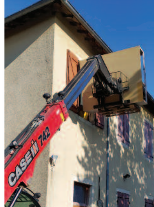
Descente du placard au manitou
