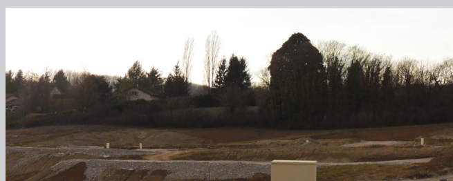
La topographie est complètement niée (ici un terrassement important)
