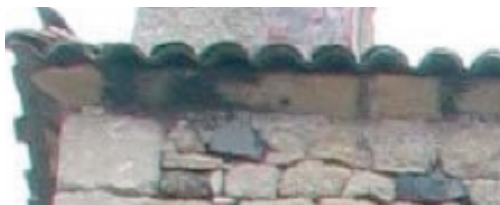
exemple de bas de pente sur corniche
