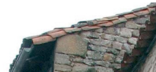
exemple de rive scellée au mortier de chaux, à droite détail de pose.
