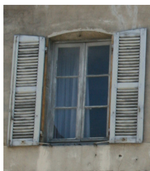
Volets persiennés et fenêtre à grands carreaux
