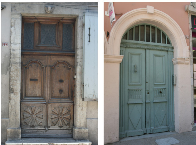
Portes bois à panneaux, panneaux inférieurs pouvant être décorés et impostes pouvant être vitrés.
